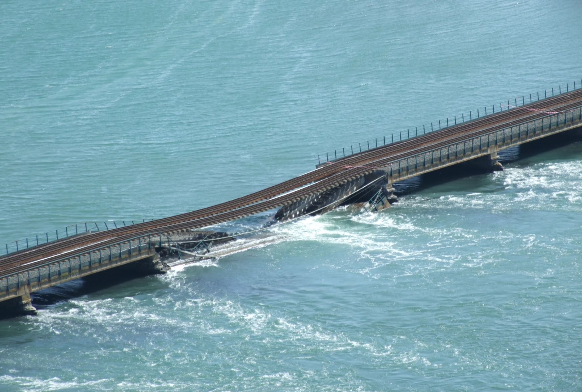
Malahide Viaduct Collapse 090821
