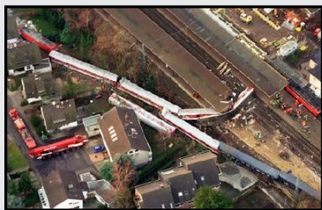
Brühl (DE) Derailment - 2000
